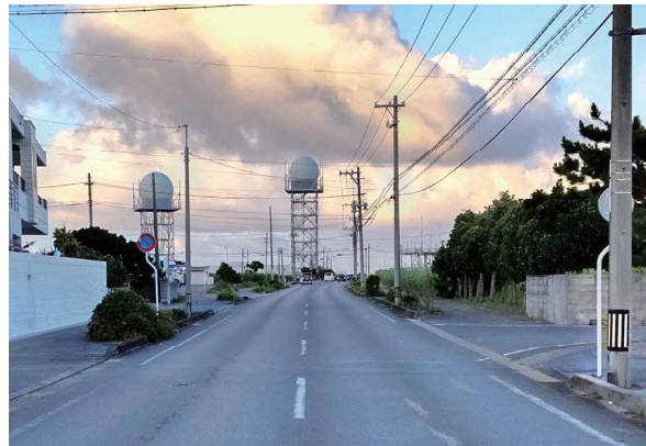
整備された道路
