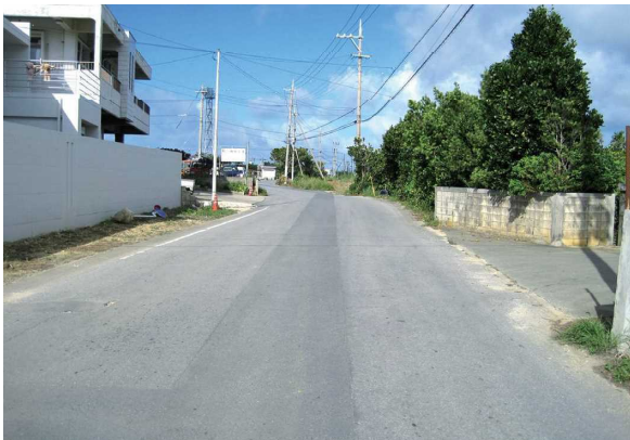
未整備の道路
